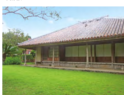
屋部の久護家 明治39年に造られた県指定有形文化財。
